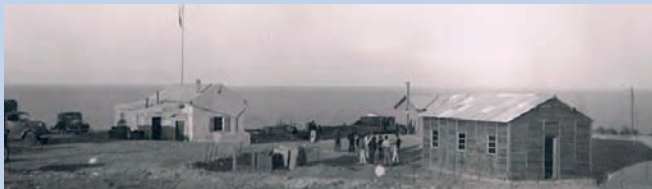
Logements et hangars de la batterie de Nemours
